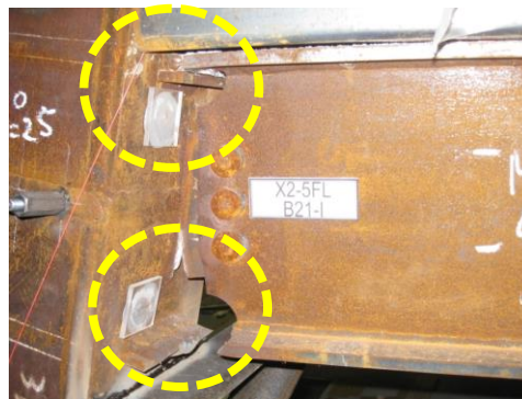
梁端フランジの破断
