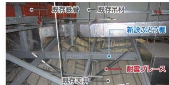
補強後の様子
