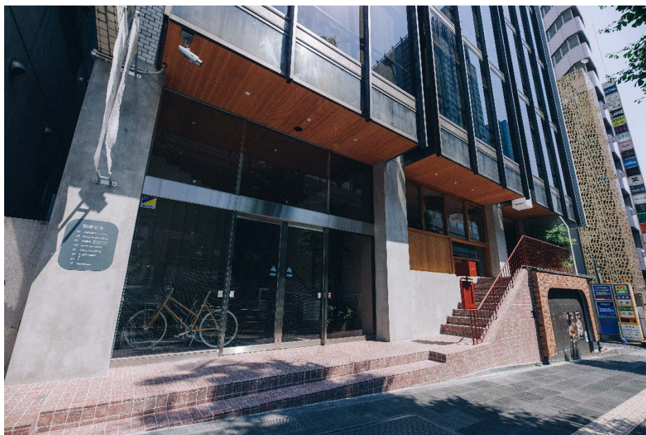
Kant. エントランス
