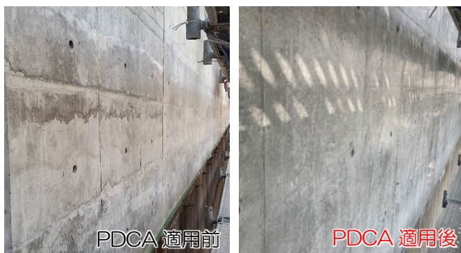
水処理施設工事におけるコンクリート表面
