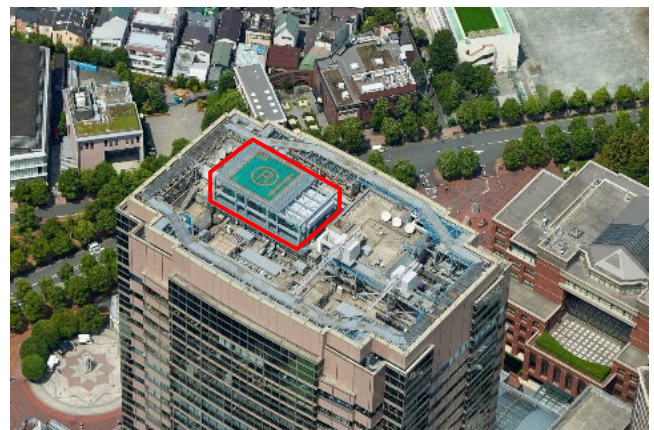
制震工事後の屋上の様子
