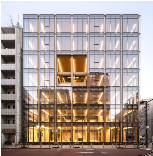
完成した新本社ビル
