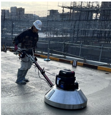
防音カバー付き電動ハンドトロウエル
