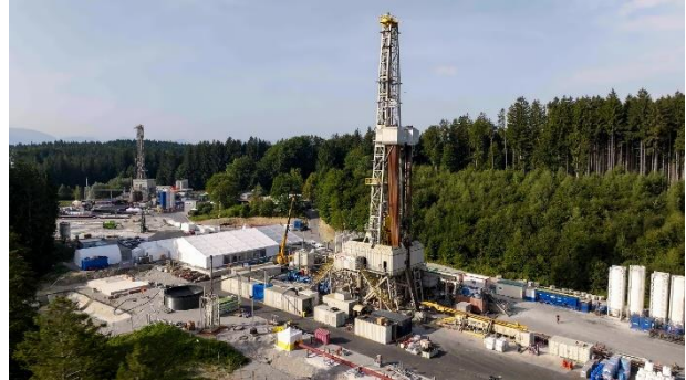
ドイツ・ゲッツリードで建設中の「Eavor-Loop」
