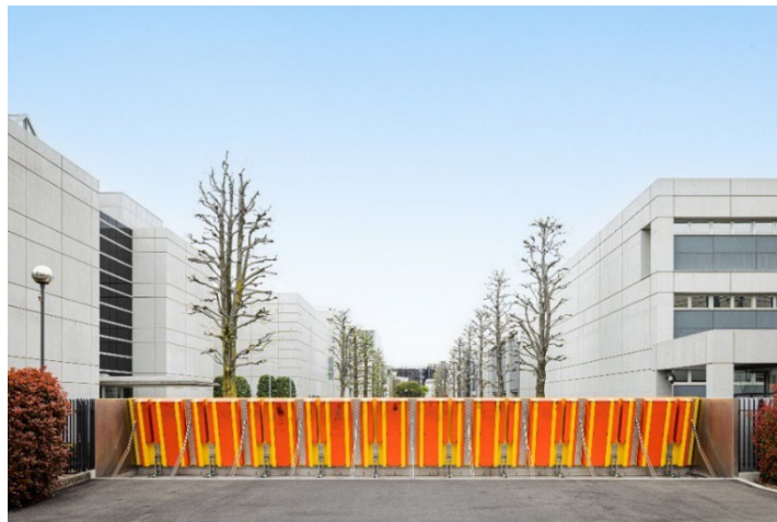
浸水発生時に自動的に立ち上がる浮上起伏式止水板
