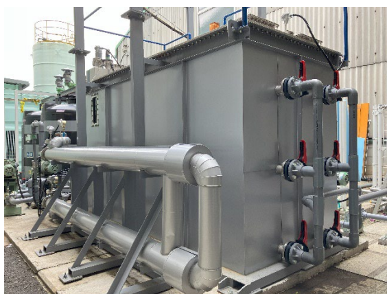
実証試験の状況
