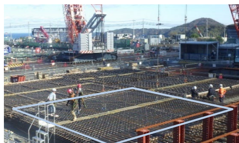
完成した鉄筋ユニットの仮置き(11mx11m)
