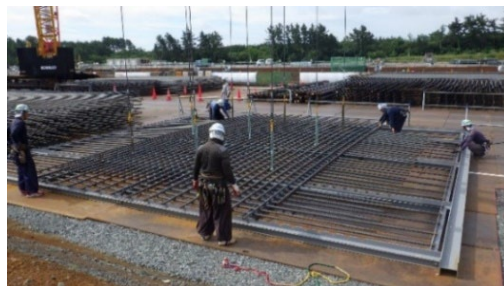
従来工法による組立状況
