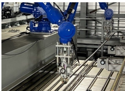
配筋ロボットによる自動配筋 (径 D38、長さ 10m、200mm ピッチ)
