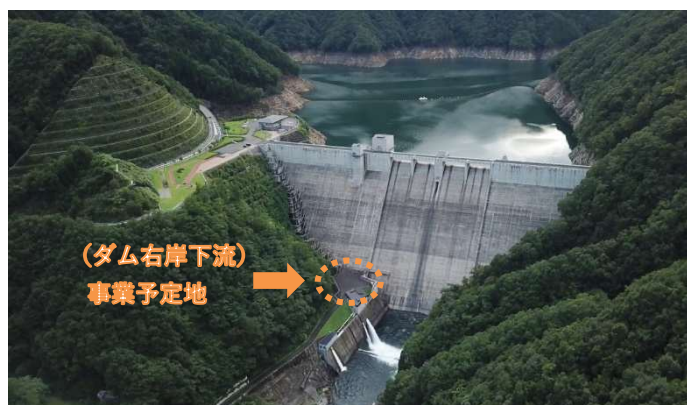
湯西川ダムの下流から望む
