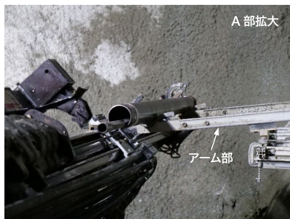
アーム部からドリルジャンボに鋼管が渡される様子
