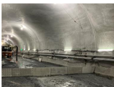
CO 2 -SUICOM 埋設型枠の設置
