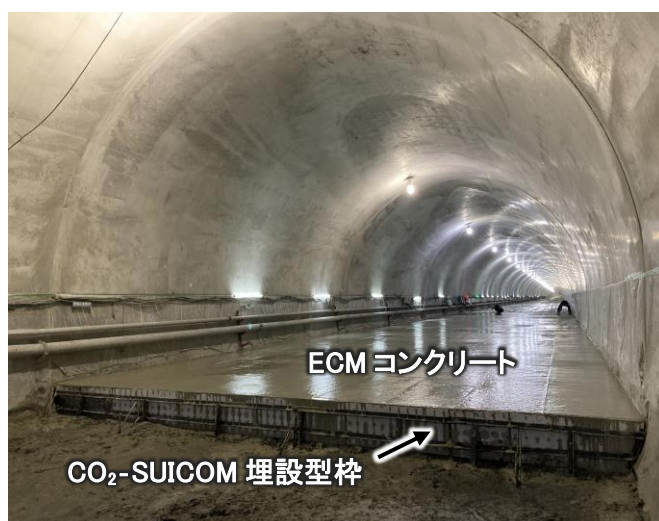
2 種類の環境配慮型コンクリートで施工したインバート
