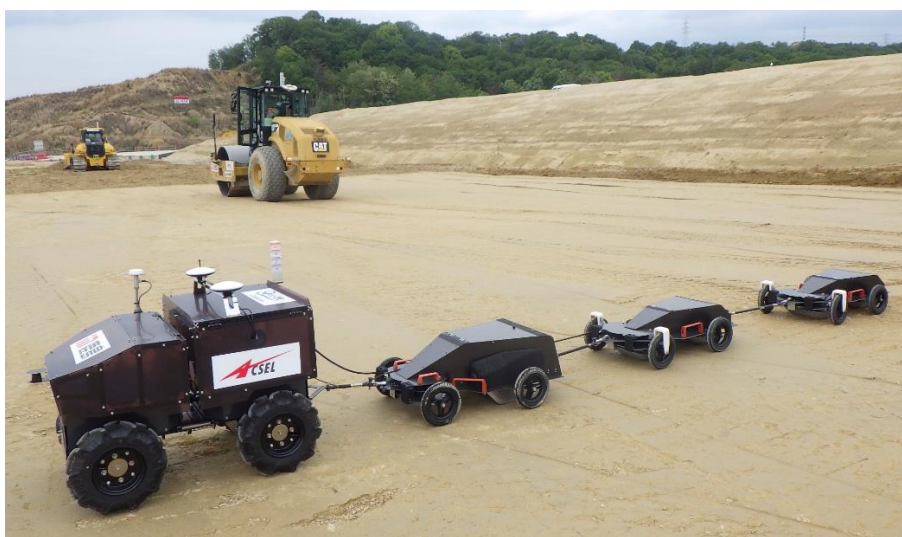
A 4 CSEL AGV の牽引で Geo-DX Compaction が盛土の締固め品質を測定中
