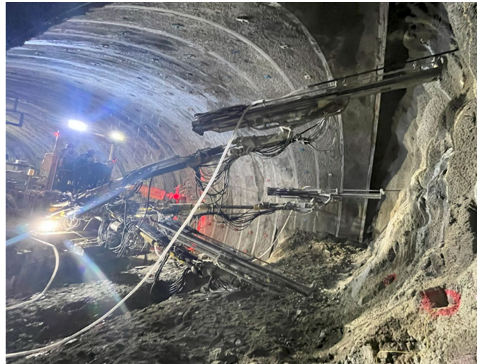
遠隔爆薬装填法の現場適用の状況
