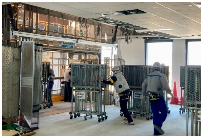
従来の作業状況(左:天台を床状に敷き並べた様子、右:天台を仮設エレベータで移動)
