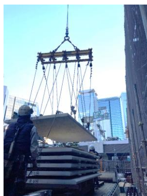
現場搬入状況
