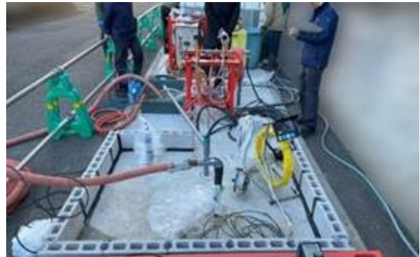
実証試験で FenMix を地盤に注入している様子
