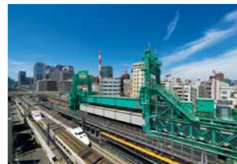
Iグループ:東北縦貫線建設工事-新幹線直上での鉄骨・PC桁・鋼桁架設、既設新幹線構造物の補強
