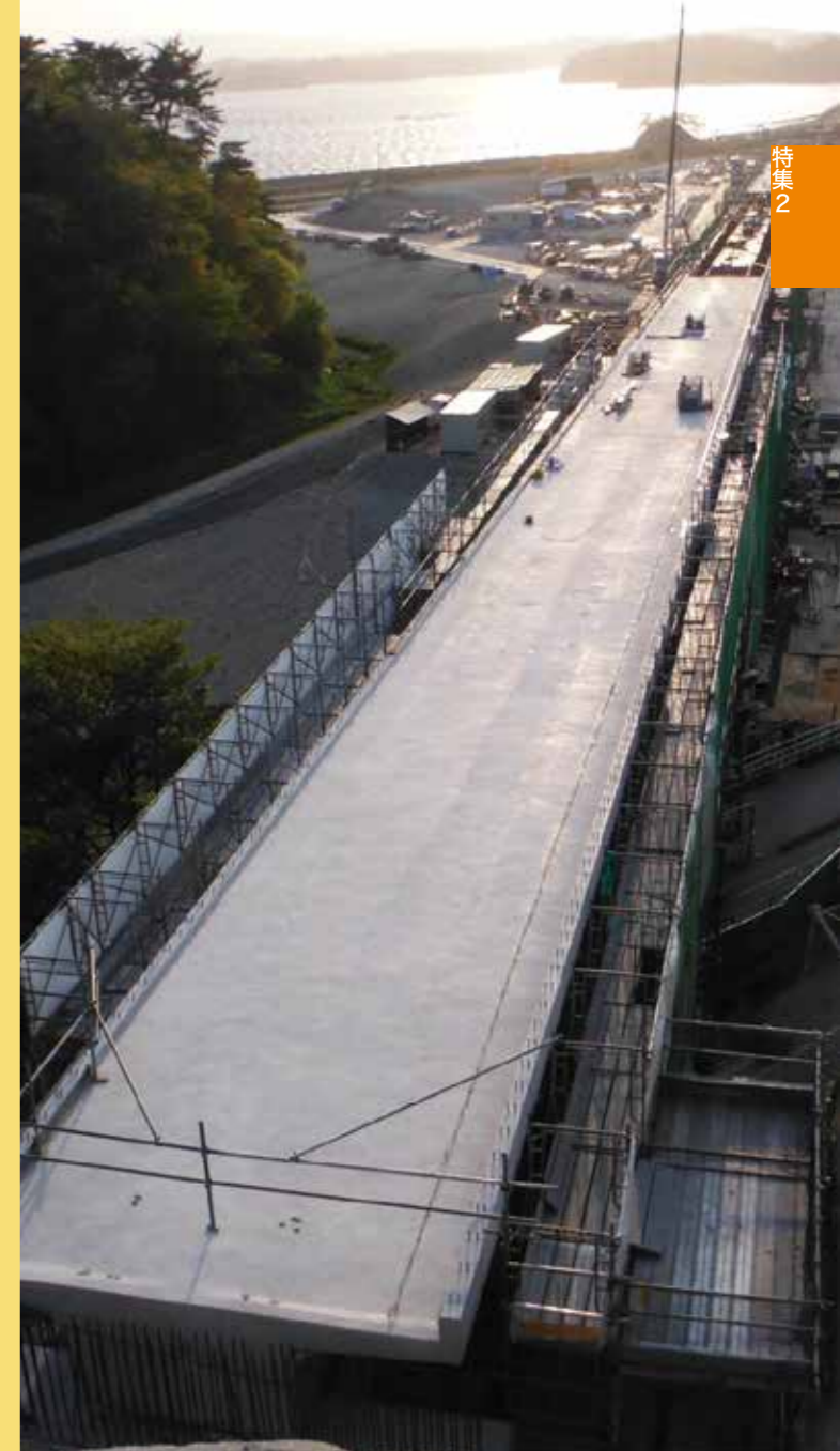
仙石線東名工区で施工中の高架橋
