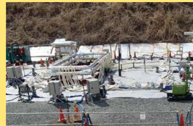
凍土遮水壁の実証
