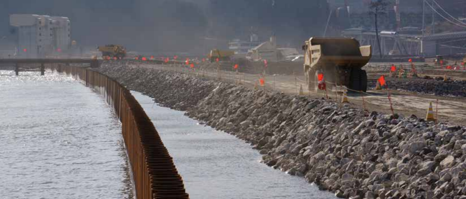
陸前高田の防潮堤築造
