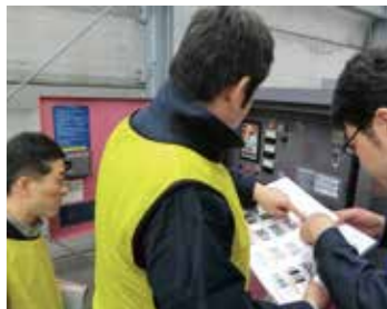
休日BCP訓練で技術研究所 の非常用電源操作
