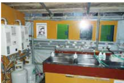
▲優秀賞の圏央道桶川地区函渠工事事務所(埼玉県)。現場で発生する地下水を用いて「足冷やし場」を設置。熱中症対策のひとつになった
