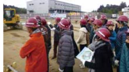
京都大学地球工学科国際コースの学生35名が見学(熊本県公共圏管理型最終処分場建設工事・熊本県)
