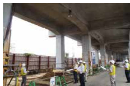
目視調査状況
