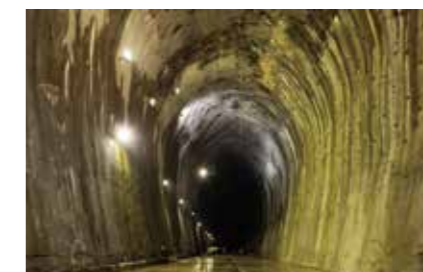
IIグループ: 倉敷・波方国家石油ガス備蓄基地の建設-地下150mに我が国初の水封式LPG岩盤貯槽を建設
