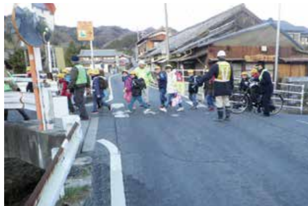
地元小学生の通学路で交通誘導を実施している(三田坂トンネル工事・三重県)
