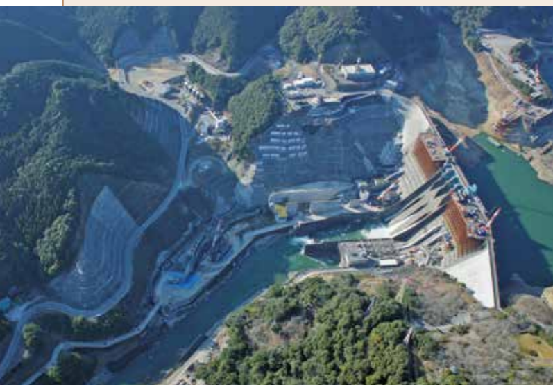
ダム再開発工事中の鶴田ダム
