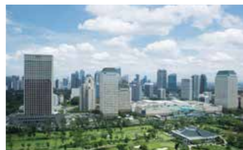
ショッピングセンター、オフィスビル3棟、アパート4棟、ホテル複合棟からなる大規模複合開発「スナヤン・スクウェア」(インドネシア)
