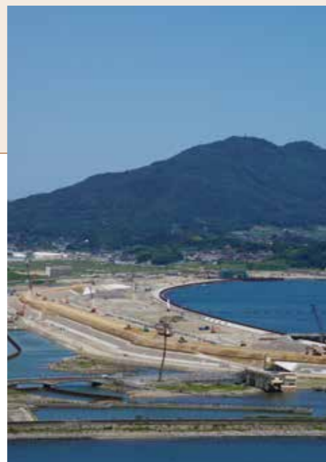
陸前高田地区における 海岸沿いの復興工事
