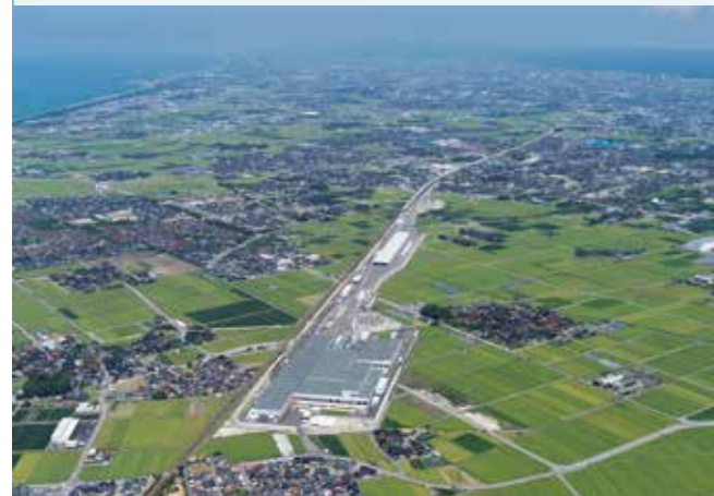
北陸新幹線 白山総合車両所
