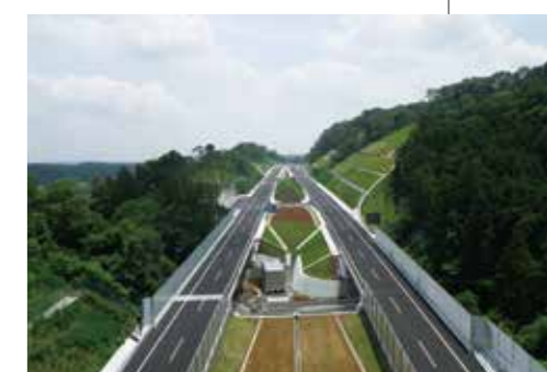
圏央道相模原愛川IC~相模原IC舗装工事
