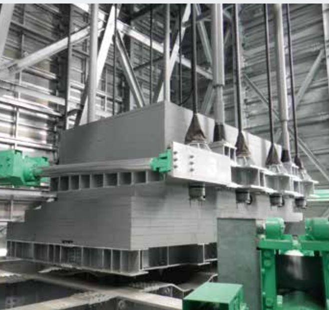
超大型TMD・D'sSKY®の内部
