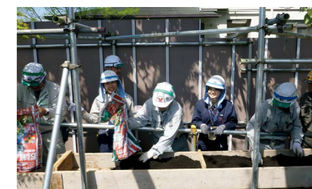
京都女子大学工事で行われている環境整備活動
