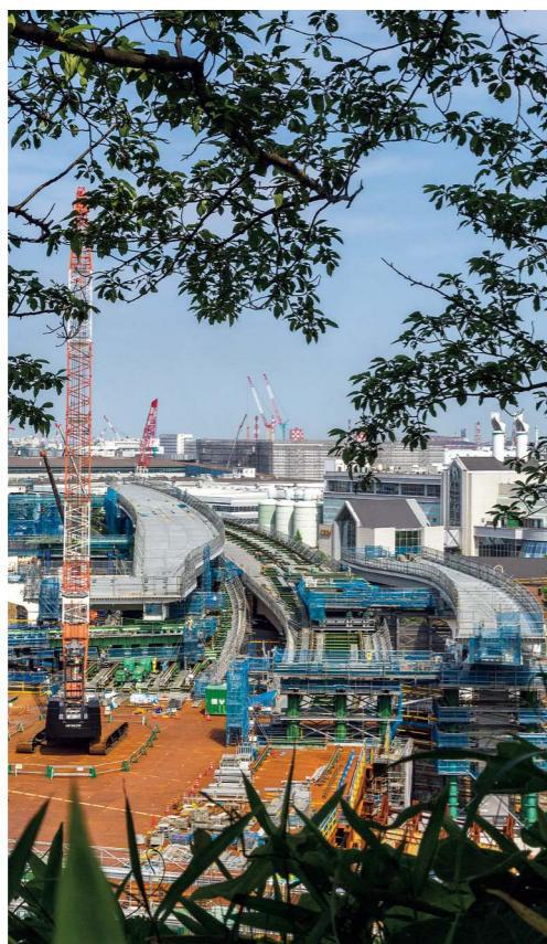
横浜環状北線交差部新設工事(横浜市神奈川区子安台～鶴見区岸谷)
