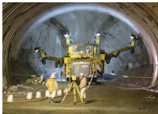
新区界トンネル
