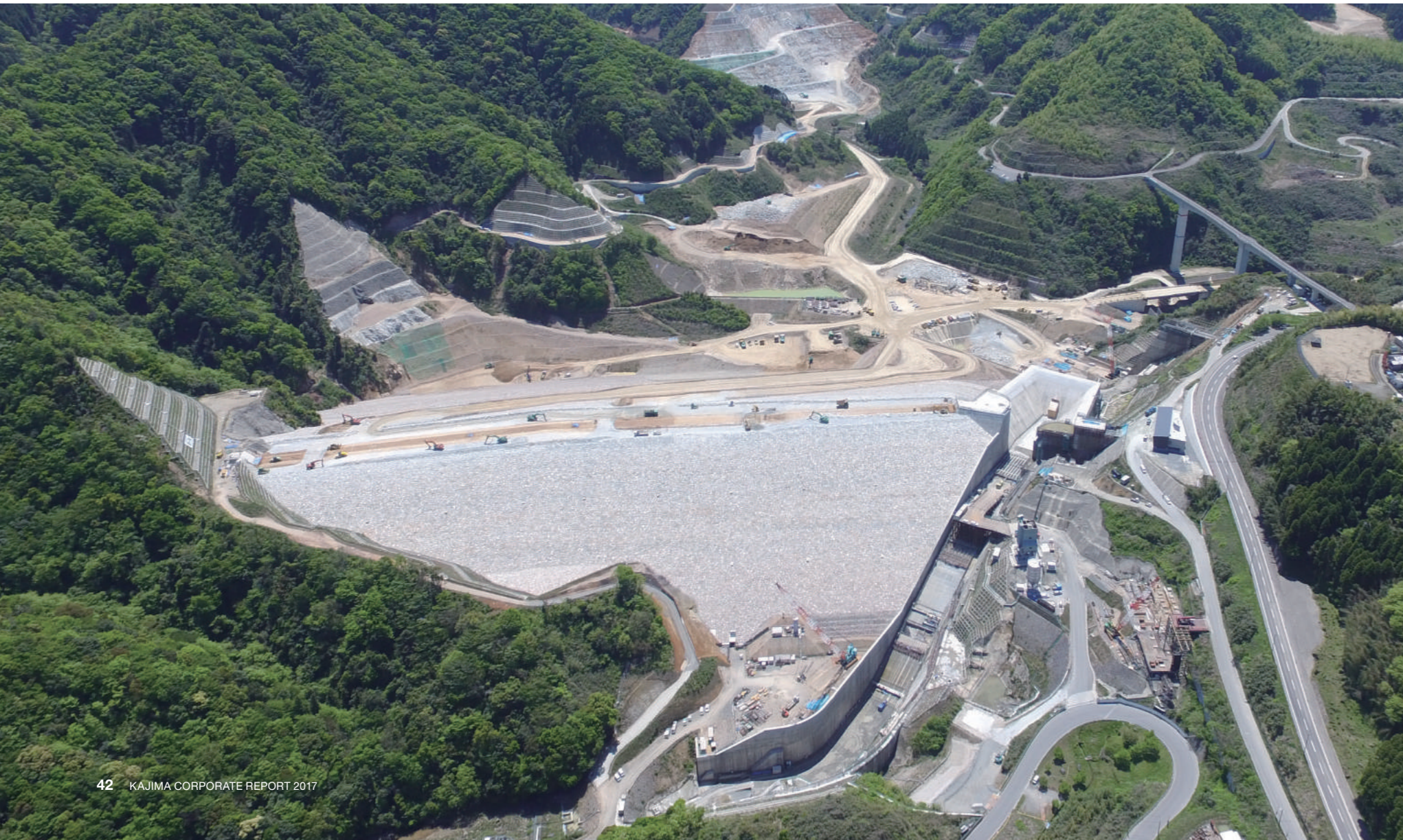
大分川ダム建設工事
