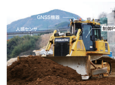
ICTブルドーザに自動化機器・装置等を搭載
