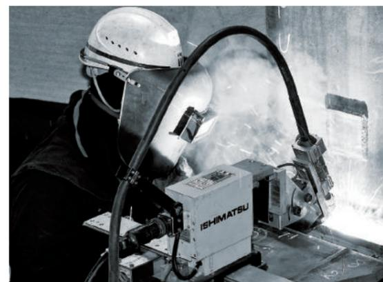
建築部門は共通のICTツール導入によって、現場運営の効率化・標準化を図るなど、建設現場での作業のあり方改革を目指しています。その一つとして、柱や梁の鉄骨の溶接作業に関して、「汎用可搬型溶接ロボット」を用いた施工方法の確立に取り組んでいます。実証実験等を進めたうえで、2現場で適用し、作業終了後の検査では熟練溶接技能工と同等の結果となりました。溶接技能工は高い技量を求められるとともに、資格取得条件が厳しいことから今後不足が予想されています。この溶接ロボットを操作するオペレータを育成するために、グループ会社の鹿島クレスに溶接事業部を足元させました。今後オペレータの育成を進め、予想される溶接技能工不足に対応するとともに、操作技量の安定化と品質の向上を目指しています。
