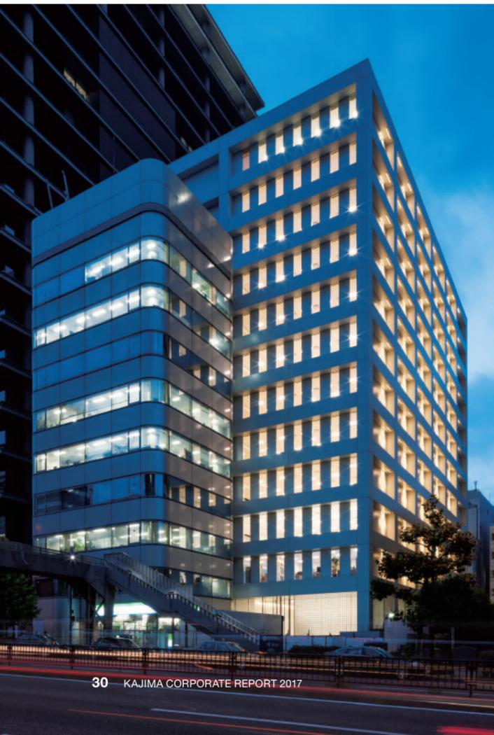
また、2016年に竣工したKTビルにおいては、設計段階からコスト合理性に配慮しながら新たな省エネ制御技術を導入し、施工段階では様々な省力化施工に取り組みました。その結果、BELS(建築物省エネルギー性能表示制度)の新基準において、54%の省エネを達成して、国内オフィスビルで初めて「ZEB Ready」(ZEBを見据えた先進建築物)を実現しました。鹿島では2020年にZEB(ゼロ・エネルギー・ビルディング)の第1号実現を目指しており、自社不動産を用いた計画・設計・施工・運用の各段階における取組みのメニュー化を進め、ZEB実現に着実に向かっていきたいと考えています。
