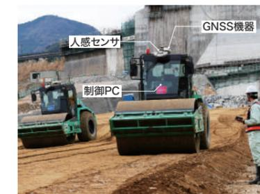
汎用の振動ローラに自動操舵装置・制御PCを搭載
