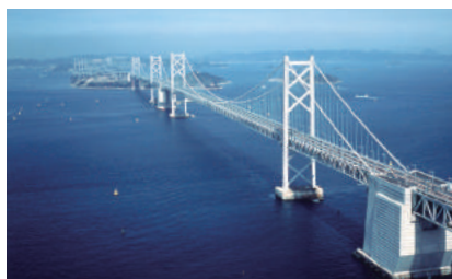
南備讃瀬戸大橋
