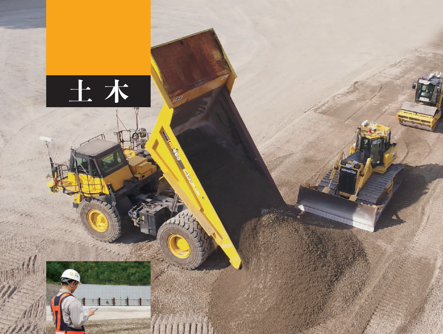
建設機械の自動化を核とした次世代の建設生産システム 「A 4 CSEL ® (クワッドアクセル)」
