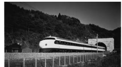
東海道新幹線・新丹那トンネル
