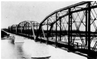
阿賀野川橋梁
