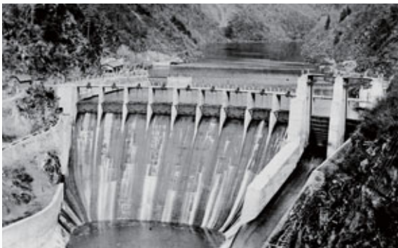
上: 矢嶽隧道(宮崎県, 1909年)。坑口前にて発注者、施工者、作業員の記念撮影 下: 日本初のコンクリート高堰堤・大峯ダム(1924年, 京都府)。1964年の天ヶ瀬ダム建設で水没
