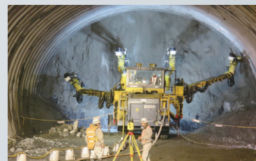
加速する土木現場の工場化 P22、42
