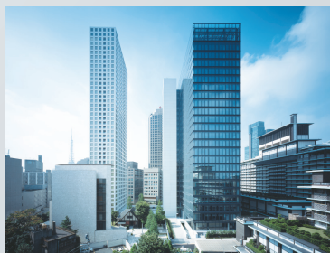
東京の中枢・虎ノ門の丘に建つ23階建ての賃貸オフィスと41階建ての分譲レジデンスからなる虎ノ門タワーズ (2006年)
