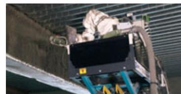
耐火被覆吹付ロボットによる施工状況 など
