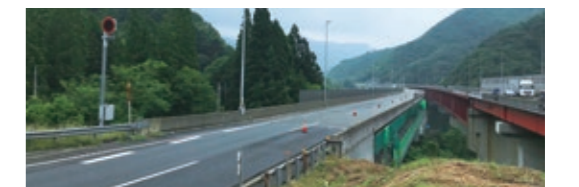
SDRシステムを採用し床版更新工事が行われる関越自動車道 阿能川橋
