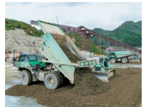
「A 4 CSEL」により堤体打設を行う成瀬ダム
