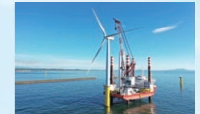
国内最大級の洋上風力発電施設建設工事
