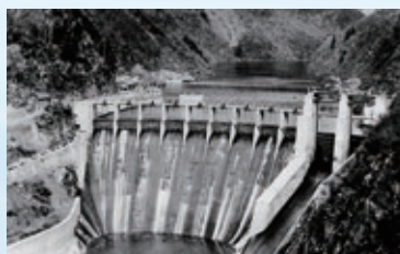
日本初のコンクリート高堰堤・大峯ダム(1924年、京都府)。1964年の天ヶ瀬ダム建設で水没
