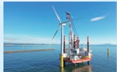
国内最大級の洋上風力発電施設建設工事
