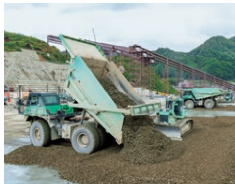
「A 4 CSEL」により堤体打設を行う成瀬ダム
