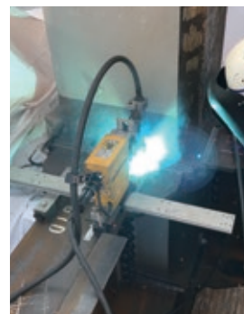
可搬型溶接ロボットによる超狭開先溶接
