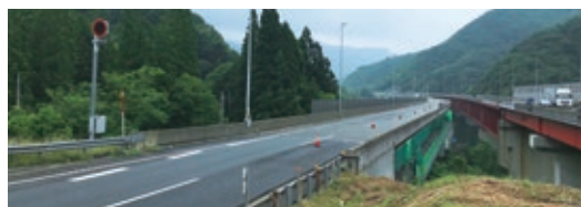
SDRシステムを採用し床版更新工事が行われる関越自動車道 阿能川橋
