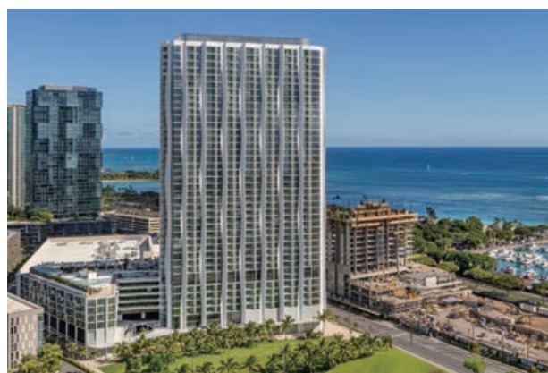
KŌ'ŪLA(ハワイ州/HDCC施工)
