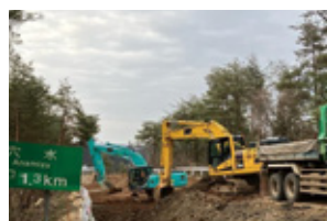
のと里山海道の復旧工事
