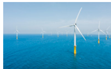
秋田港・能代港洋上風力発電施設建設工事 (2023年完成/秋田県)
