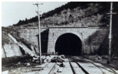
丹那トンネル(1934年完成/静岡県)
