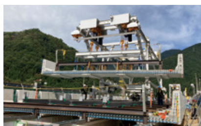
関越自動車道阿能川橋における新設床版の架設
