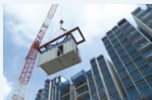
現場の生産性向上を実現するモジュール工法
