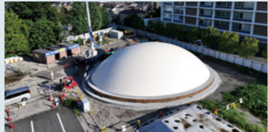
鹿島技術研究所隣地で試験施工したCUCO-SUICOMドーム
