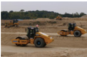
自動化改造した2台のローラによる連携作業(岡崎市阿知和地区工業団地造成事業)。詳細は上記二次元コードよりご確認いただけます
