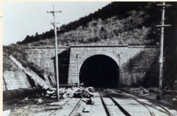
丹那トンネル(1934年完成/静岡県)
