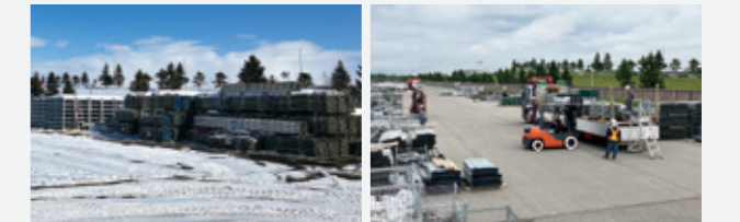
Rapidus IIM-1 建設計画仮設材の仮置き、仕分ヤード
