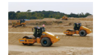
自動化改造した2台のローラによる連携作業(岡崎市阿知和地区工業団地造成事業)。詳細は上記二次元コードよりご確認いただけます
