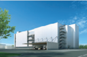
「ソムラ茨城工場 造粒包装棟建設工事」 (茨城県)
