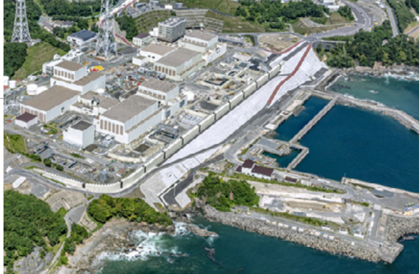
東北電力女川原子力発電所
