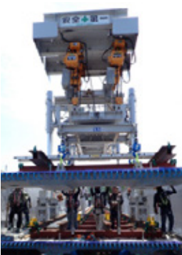
新設床版の架設状況
