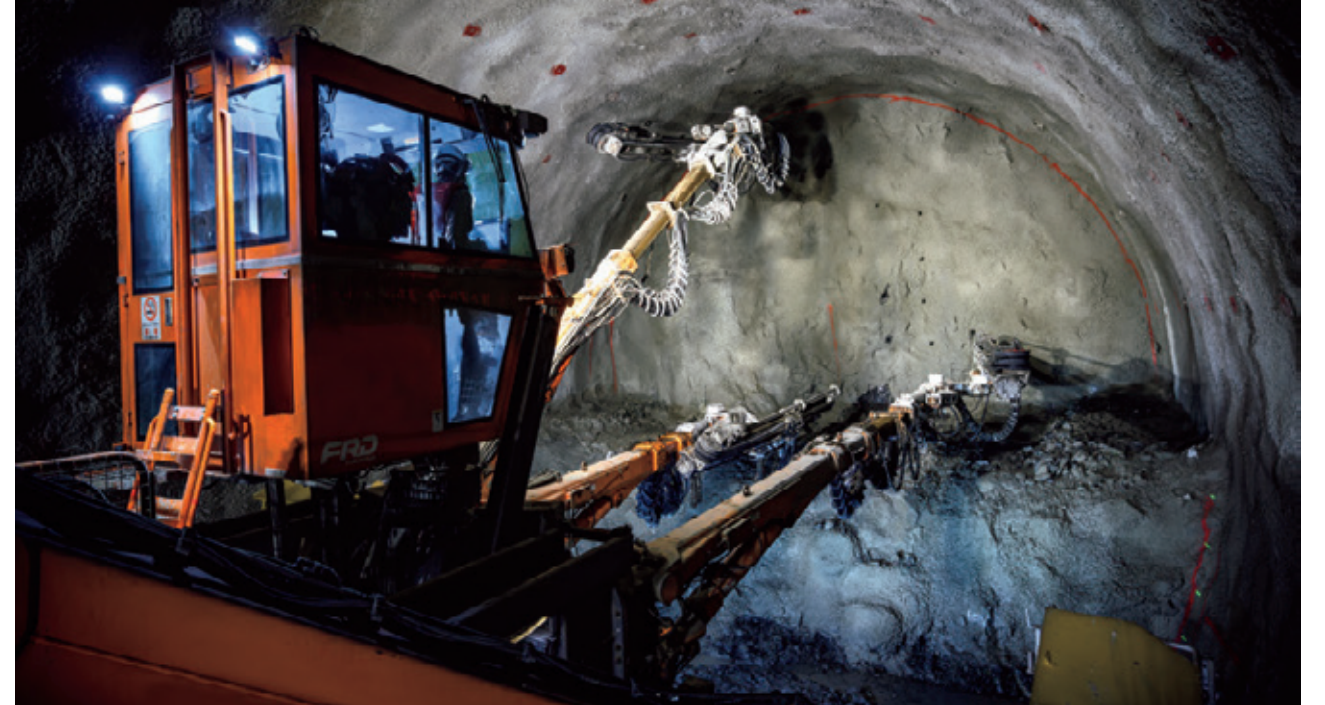
札幌トンネル工事に適用しているA 4 CSEL for Tunnelの自動穿孔
