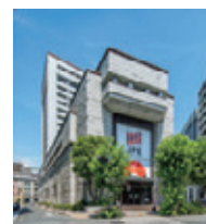
「東京証券取引所ビル本館」(東京都)耐震バリューアップ工事が完了
