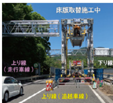
交通規制下における床版取替工事の施工状況
