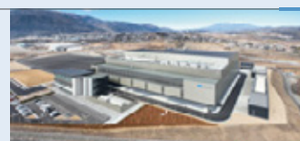
コーセー南アルプス工場
