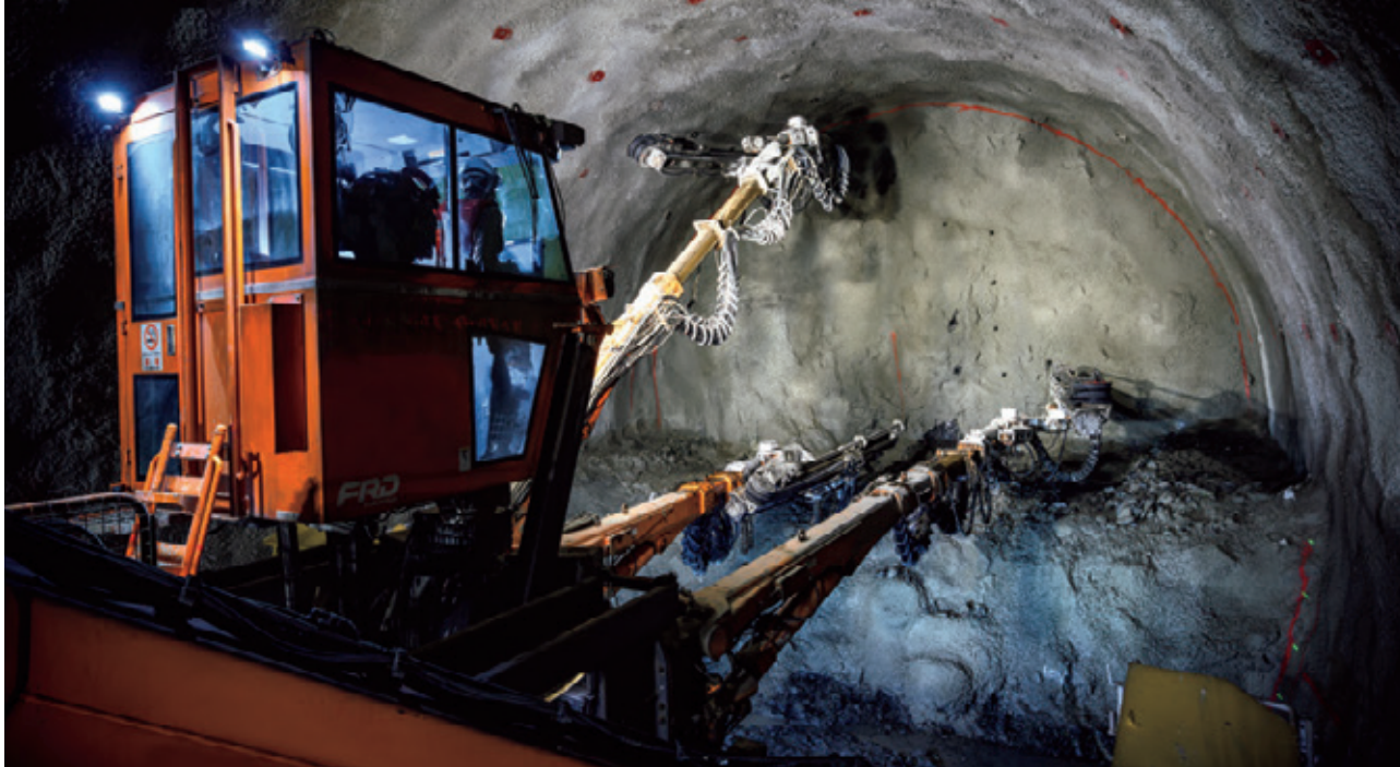
札幌トンネル工事に適用しているA + CSEL for Tunnelの自動穿孔
