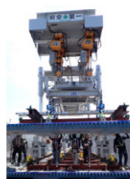
新設床版の架設状況
