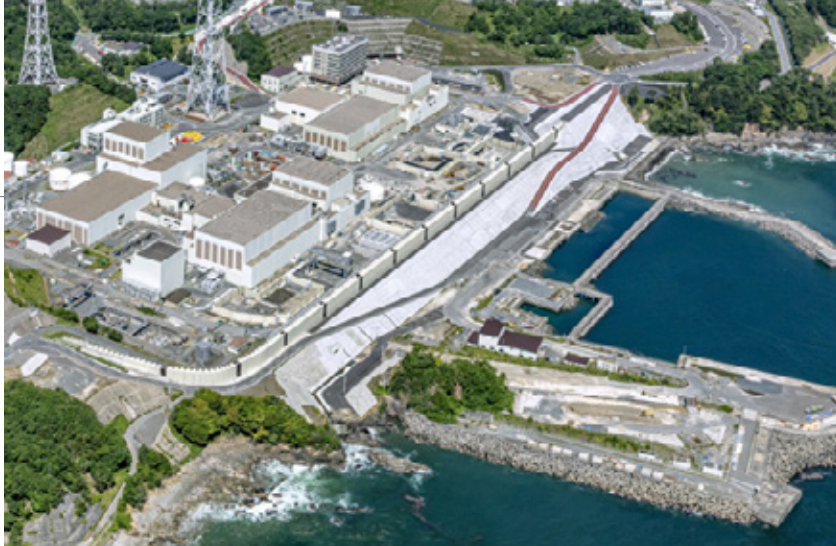
東北電力女川原子力発電所
