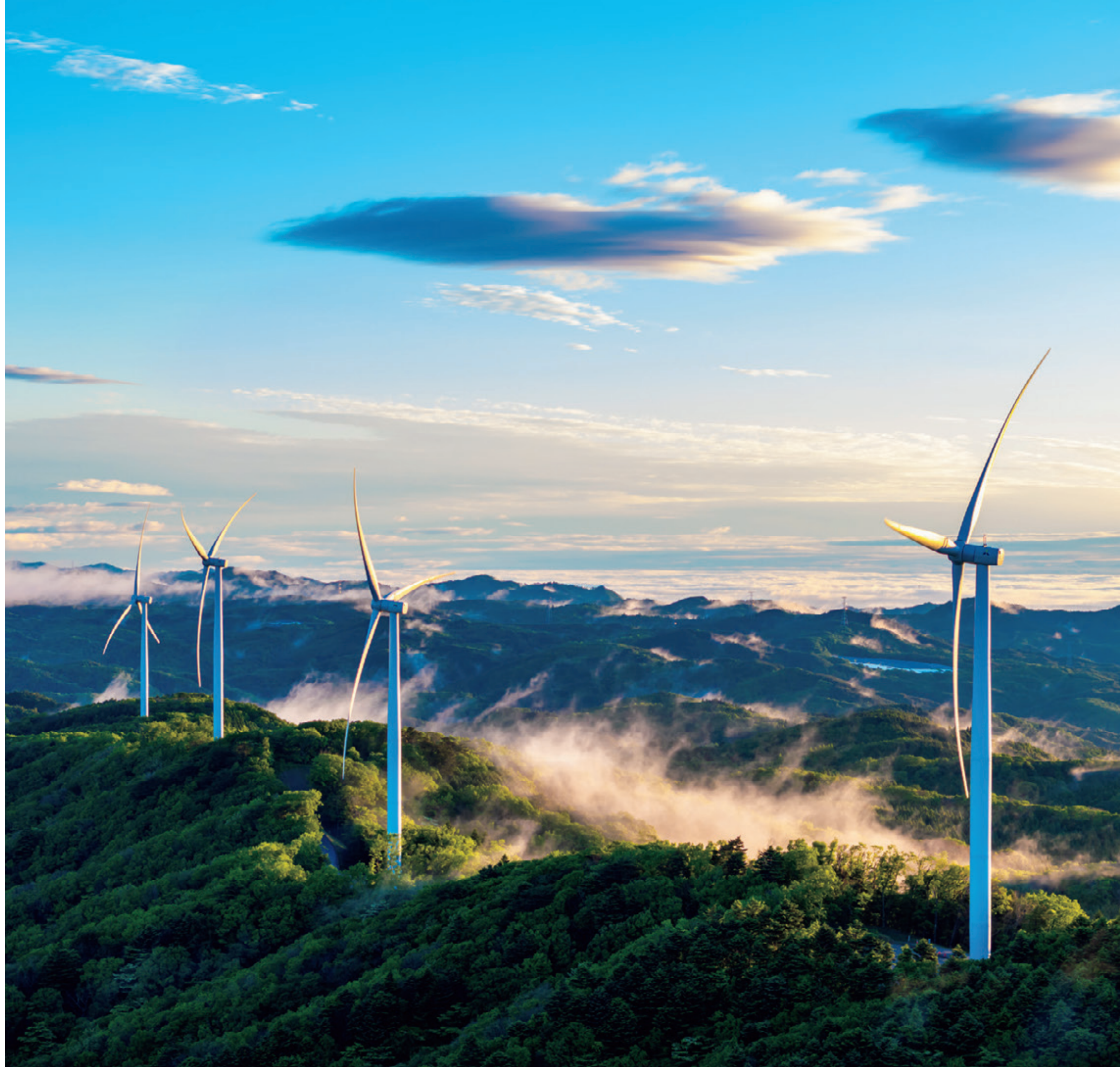
神楽山風力発電所(福島県)
