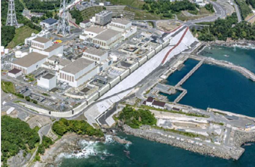
東北電力女川原子力発電所
