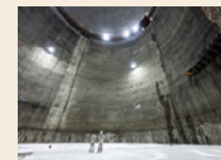
神岡鉱山地下で掘削が完了したハイパーカミオカンデ空洞
