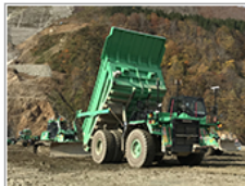
PROCESS-1 ダム本体部材の運搬・荷下ろし
