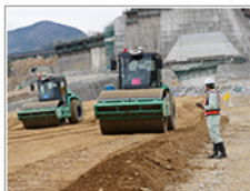
PROCESS-3 振動ローラ・章動ローラによる 締固め作業
