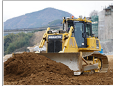
PROCESS-2 ブルドーザによるまき出し・ 整形
